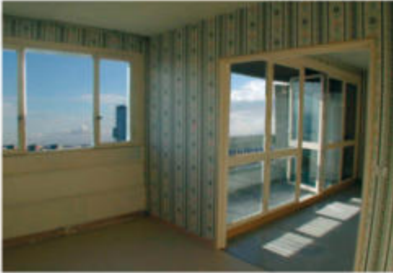
14 e planta - Antes de la transformación 14 ème étage - Avant transformation 14th floor - Before conversion
